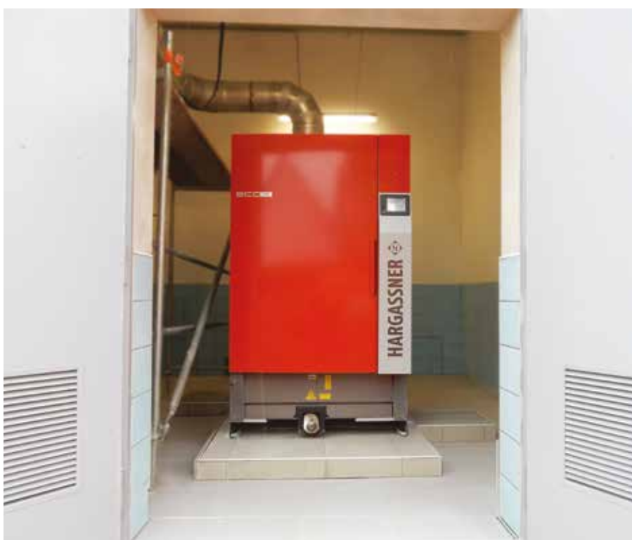
Peletový kotel, Kotelna Třešť
